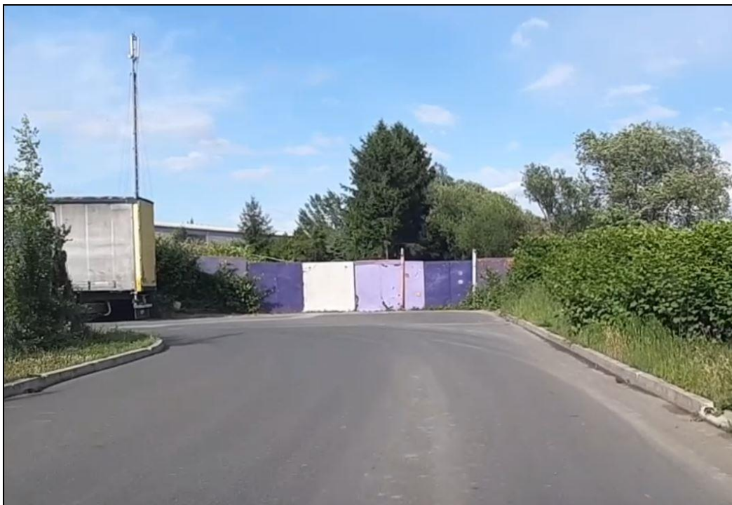
Slika 4: Lokacija krožišča na JP880522 (II. Etapa)
