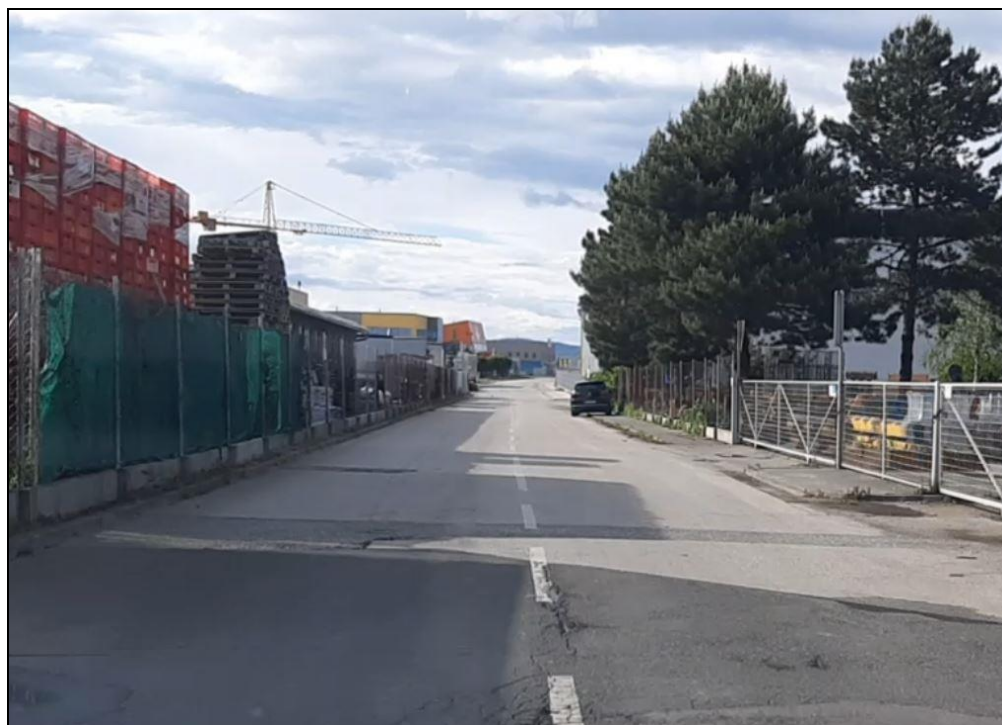
Slika 5: Rekonstrukcija obstoječe JP880522 (II.etapa)
